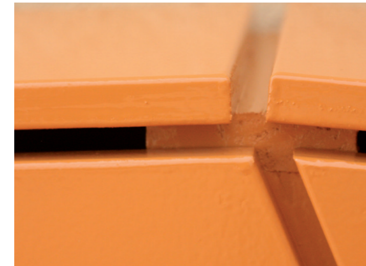
Afbelding 1. Voorbeeld van goed afronden, ventileren en dilateren van plaatmateriaal.
